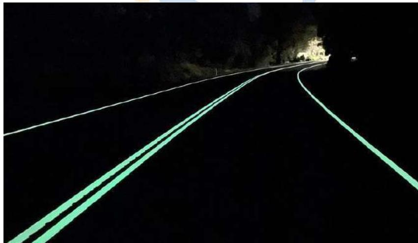
*Ilustración 48 - Ejemplo vía con pintura fotosensible*
